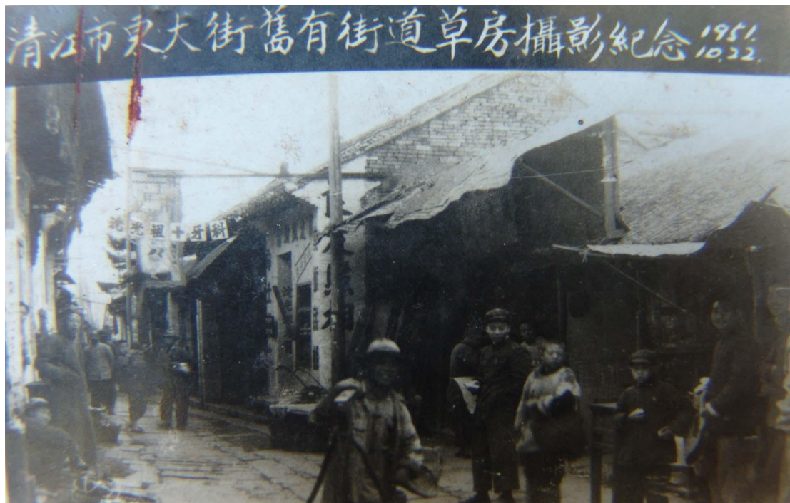
1951年10月22日，清江市东大街旧有街道草房，淮安市档案馆藏，档号：D018-1951-003-0001-0024
